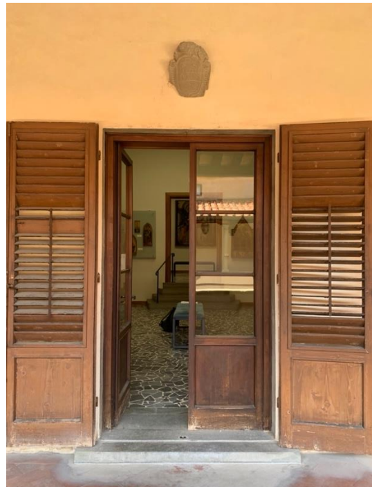
Gradino sull'uscita sul chiostro
