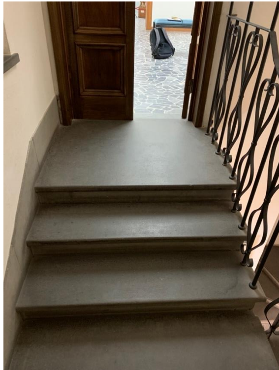
Sbarco della scala di accesso al primo piano Porta ad apertura verso l'interno, difficile leggibilità della scala dall'alto verso il basso
