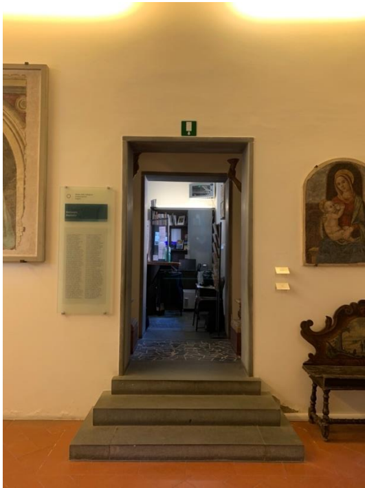
Gradini di accesso alle sale del piano terra Dello stesso materiale, privi di contrasti di luminanza e privi di corrimani
