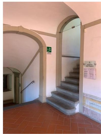
Anche lungo le scale che assumono ruolo di sicurezza i corrimani sono interrotti e non si sviluppano ambo i lati su tutta la lunghezza e i gradini non hanno una segnalazione o un trattamento che ne faciliti la percezione.
