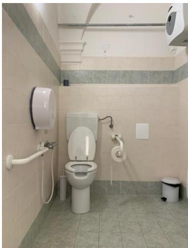
Il bagno accessibile al primo piano ha il maniglione lato muro in posizione errata, vanifica l'utilizzo da parte di persone in carrozzina nel caso di spostamenti sul water che non possono essere effettuati in autonomia.
